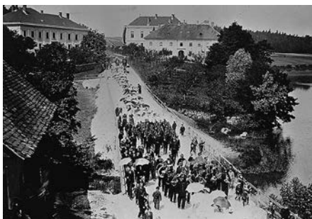
Procesija »Rešnega telesa« se pomika mimo Bolnišnice Usmiljenih bratov ter gradov Kamen in Neuhof (pred 1. svetovno vojno).
