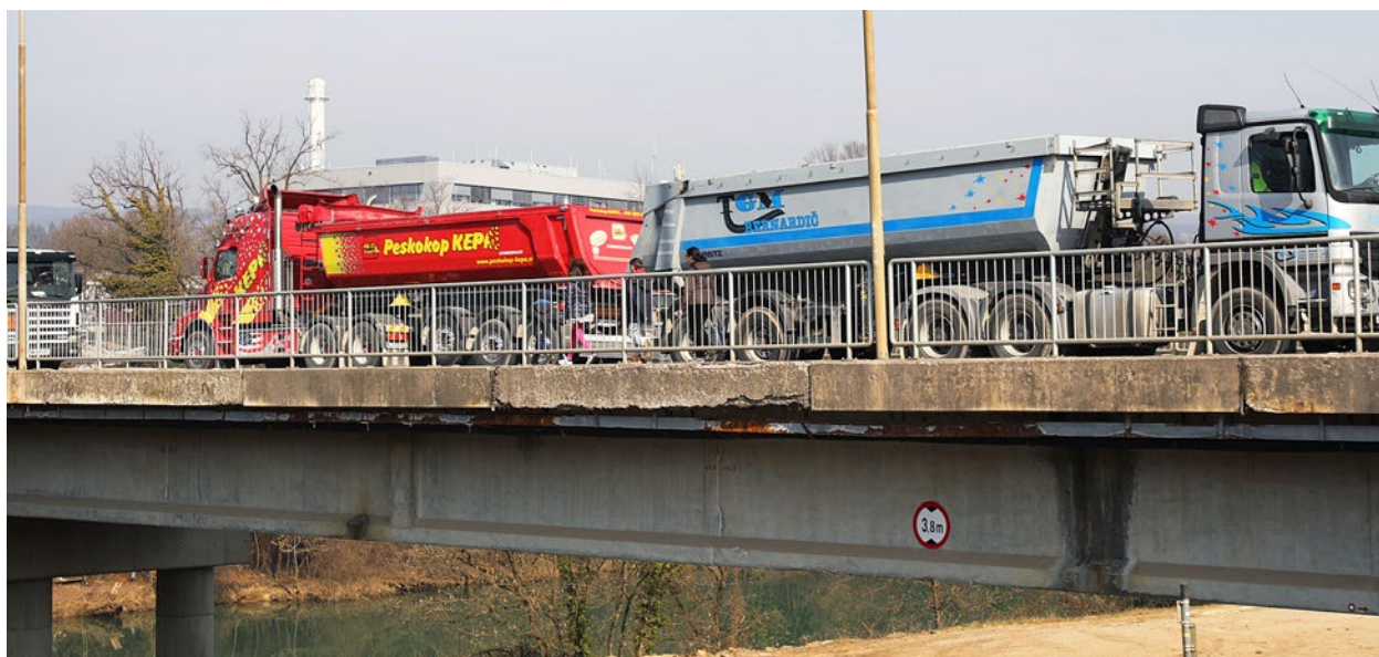
Ali je bil leta 1977 zgrajeni Ločenski most projektiran za današnje obremenitve, ki jih povzroča gost tovorni promet (foto: Boštjan Pucelj)?
