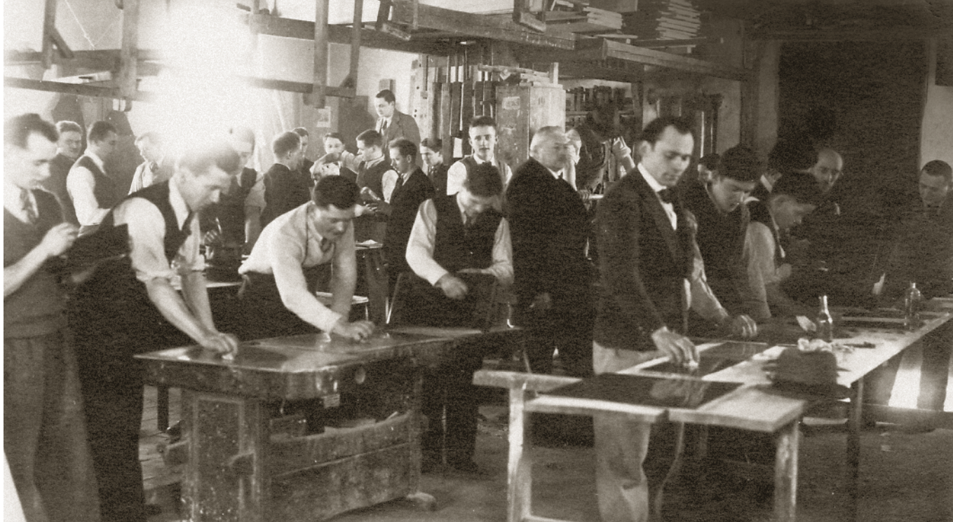
Svoje znanje so bodoči mizarji izpopolnjevali tudi na tečajih. Na fotografiji se tečajniki učijo politiranja v delavnici Karla Jevščka leta 1937. Politiranje je postopek nanašanja šelakovih raztopin v organskih topilih, ki tvorijo film, na les. Površina tako postane bolj prožna in manj občutljiva na vplive okolja (foto: arhiv družine Jevšček).
